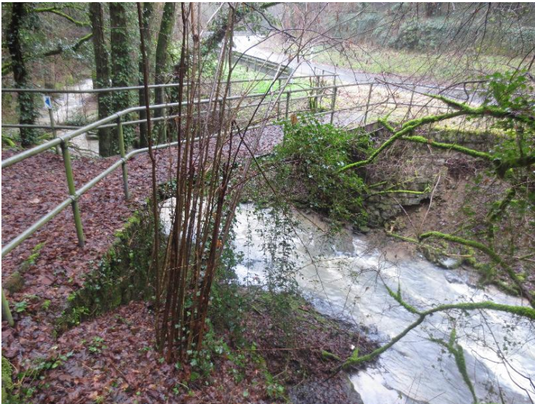
Durchlass; nicht strukturschädlich
