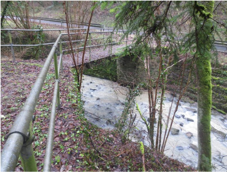
Durchlass; Ufer unterbrochen
