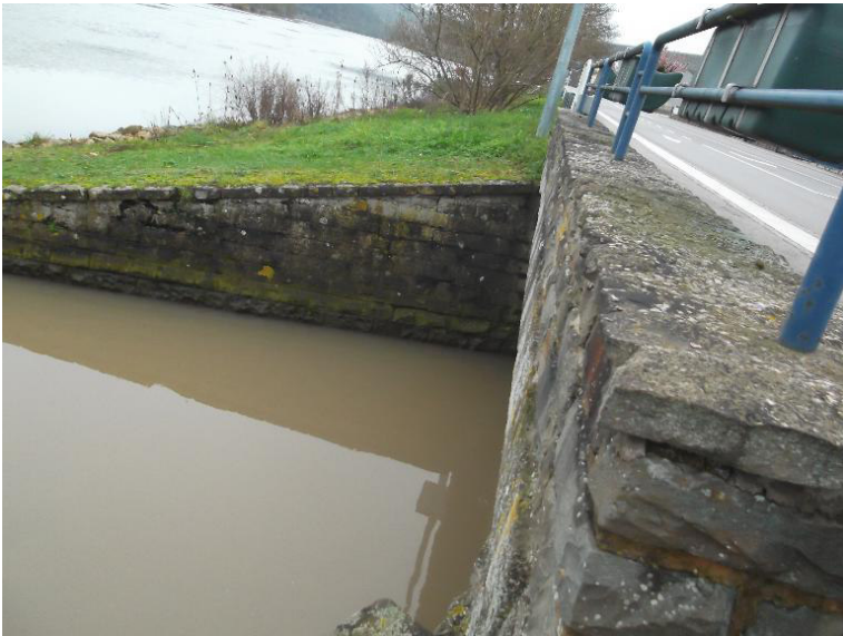
verrohrt bzw. ueberdeckt
