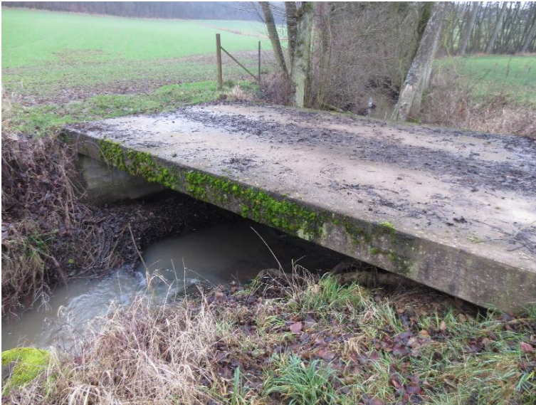
Durchlass; Ufer unterbrochen
