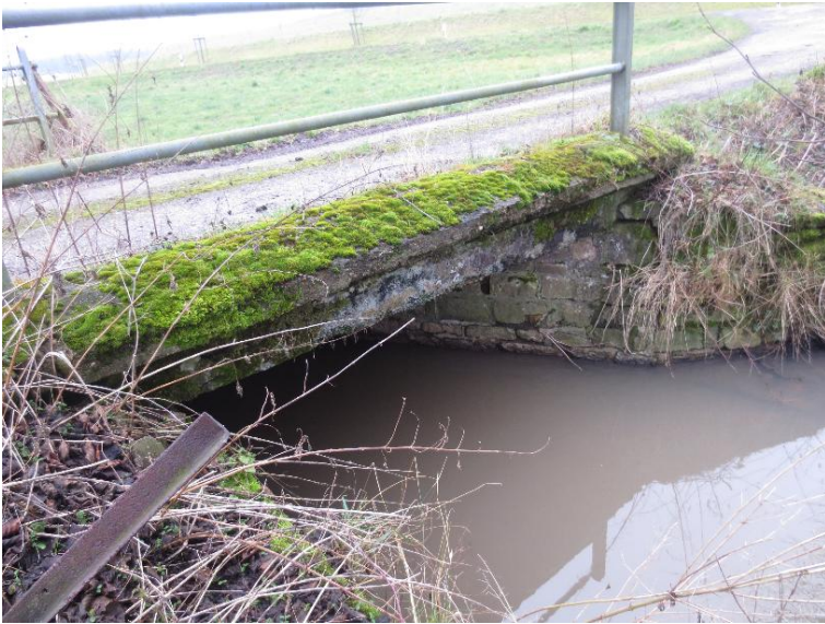
Durchlass; Ufer unterbrochen
