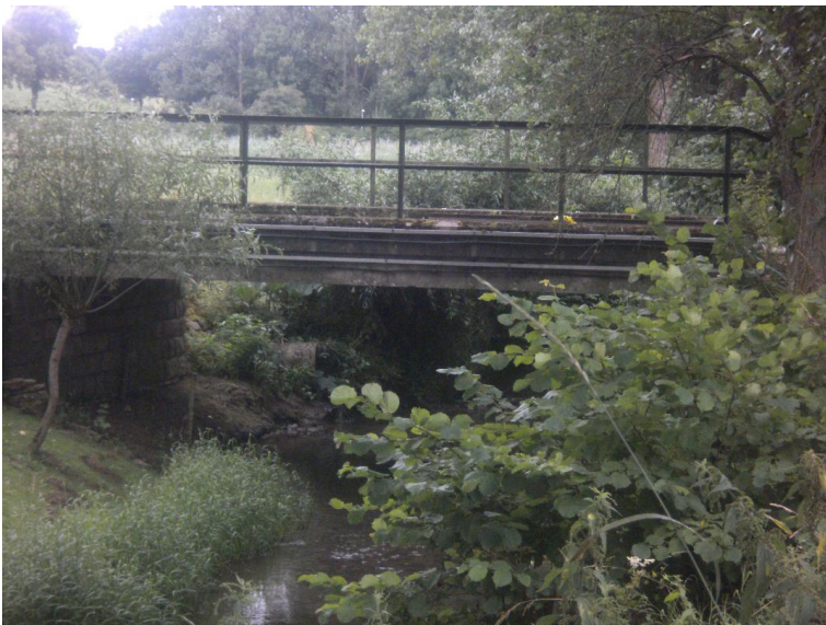
Durchlass; Ufer unterbrochen
