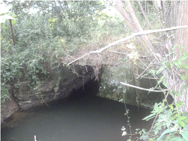
Durchlass; Ufer unterbrochen
