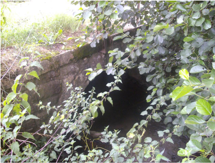
Durchlass; Ufer unterbrochen
