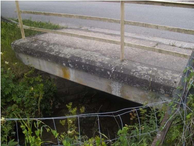
Durchlass; Ufer unterbrochen
