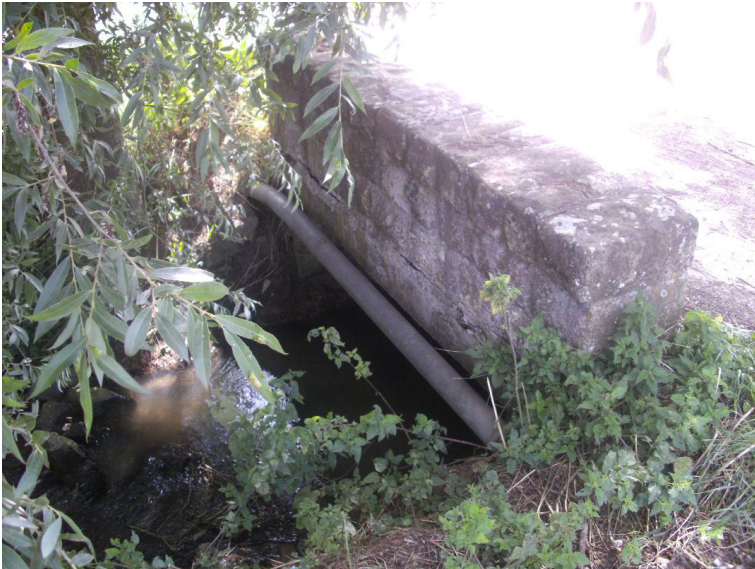
Durchlass; Ufer unterbrochen
