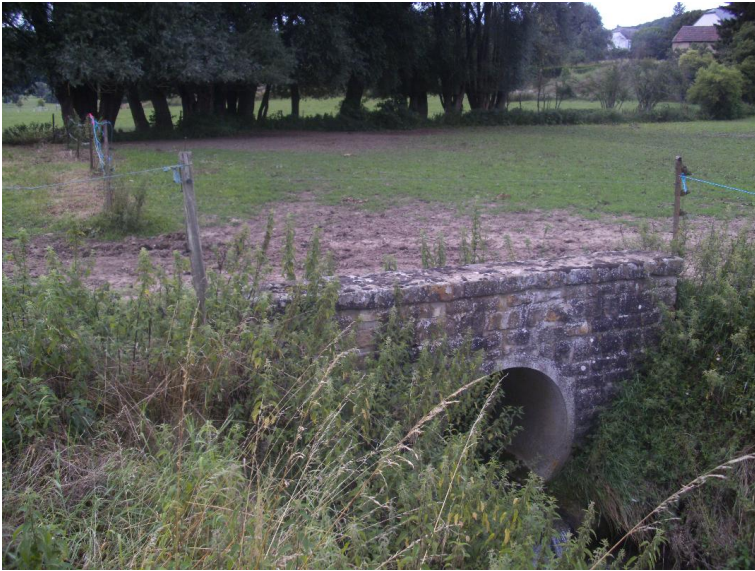
verrohrt bzw. ueberdeckt
