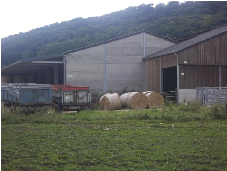
verrohrt bzw. ueberdeckt
