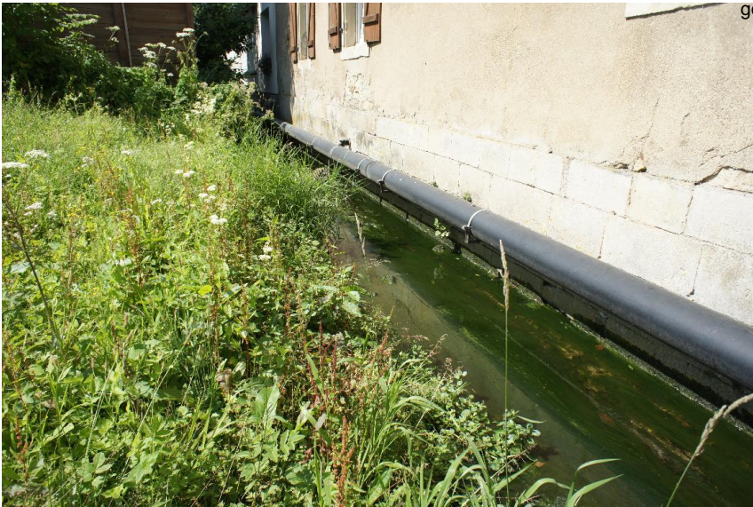
Beton, Mauer, Pflaster; verfugt - Algen
