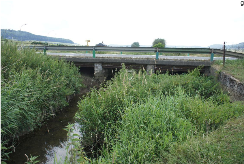
Durchlass; Ufer unterbrochen
