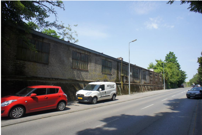
verrohrt bzw. ueberdeckt
