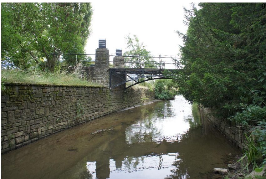
Durchlass; nicht strukturschaedlich - Kastenprofil
