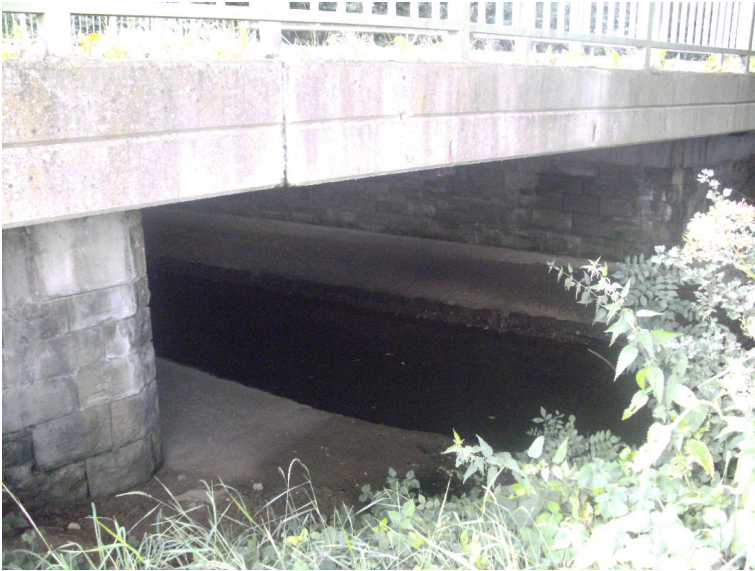
Durchlass; Ufer unterbrochen
