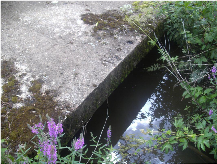
Durchlass; Ufer unterbrochen
