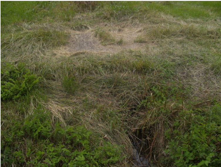
Durchlass; Ufer unterbrochen
