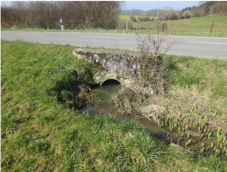
Durchlass; Ufer unterbrochen
