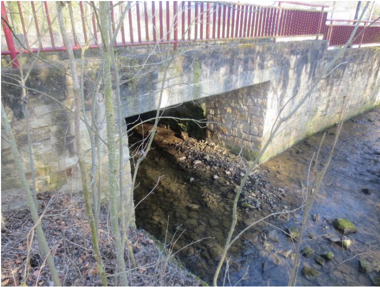
Durchlass; Ufer unterbrochen
