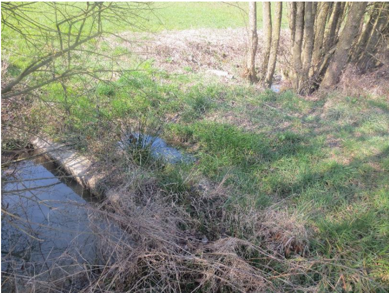
Durchlass; Ufer unterbrochen
