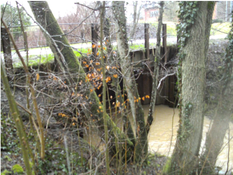
Durchlass; Ufer unterbrochen
