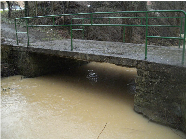
Durchlass; Ufer unterbrochen
