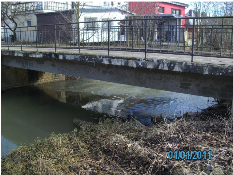
Durchlass; Ufer unterbrochen
