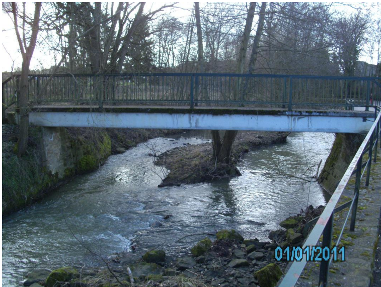
Durchlass; Ufer unterbrochen
