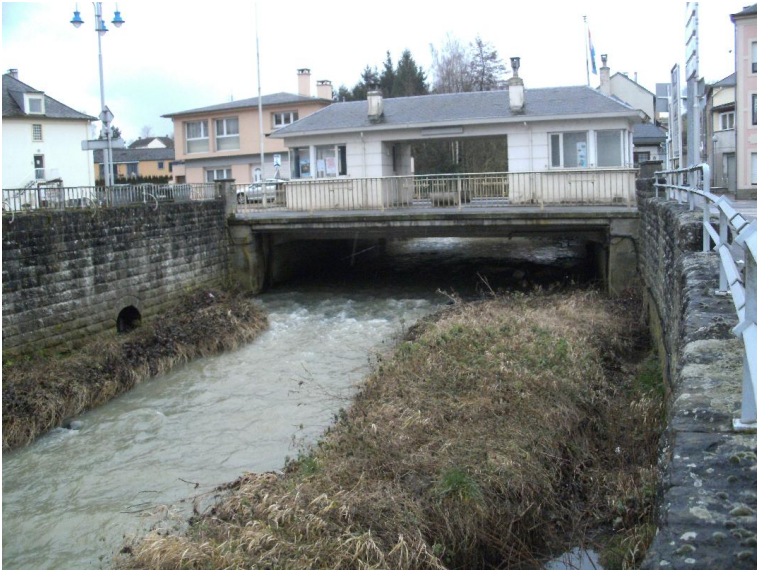
Durchlass; Ufer unterbrochen
