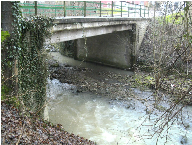
Durchlass; Ufer unterbrochen
