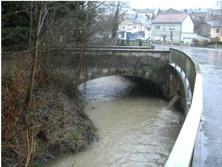
Durchlass; Ufer unterbrochen
