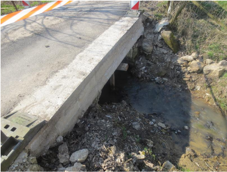
Durchlass; Ufer unterbrochen
