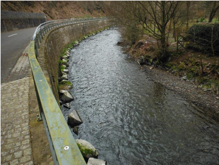
Beton, Mauer, Pflaster; verfugt
