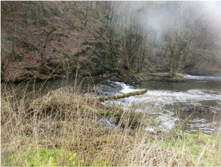
Absturz mit Umlauf
