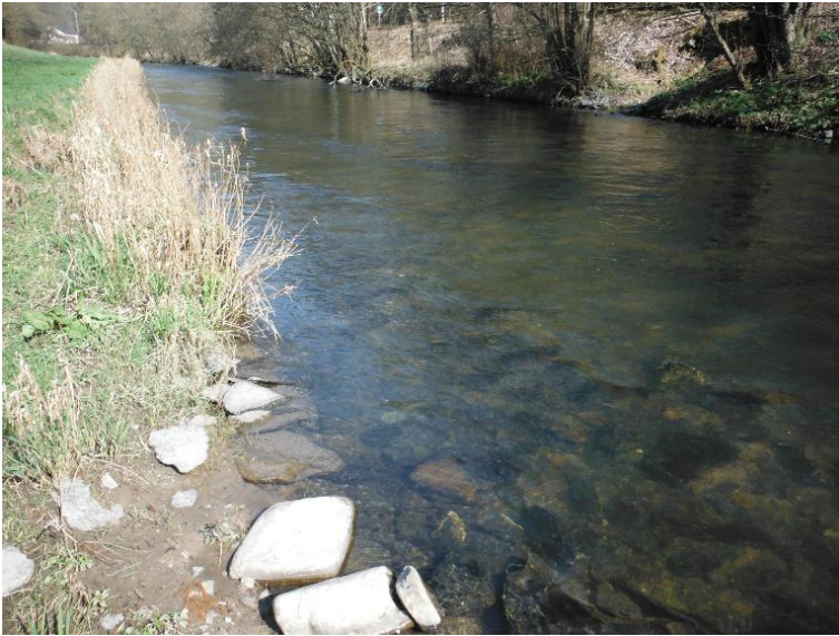
Uferverbau Steinsatz unverfugt
