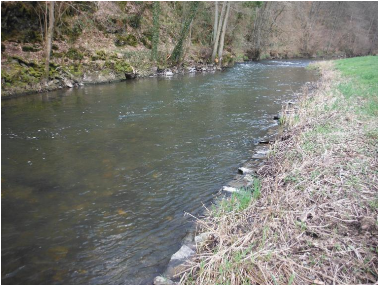
Uferverbau Steinsatz unverfugt - Uferverbau: aufbrechender Steinsatz
