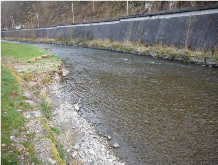
Uferverbau Steinsatz unverfugt
