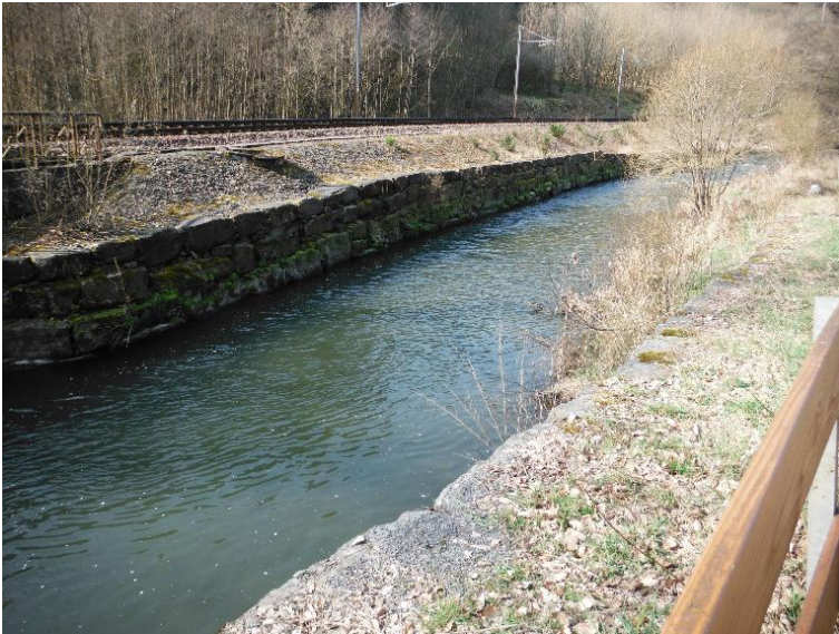
Uferverbau Steinsatz unverfugt
