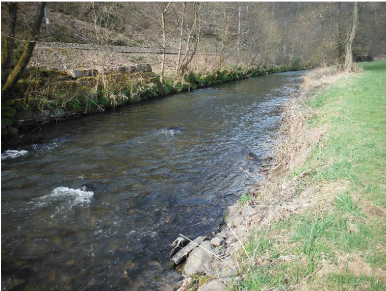
Uferverbau Steinsatz unverfugt
