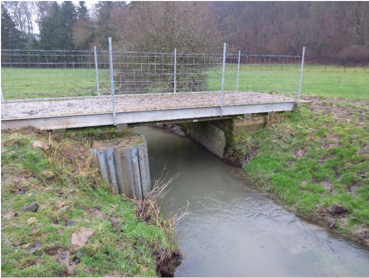
Durchlass; Ufer unterbrochen
