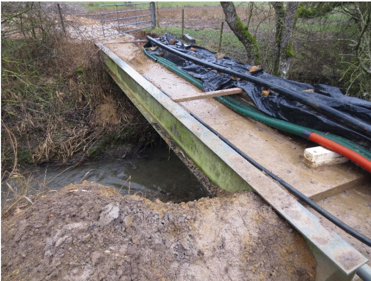
Durchlass; Ufer unterbrochen
