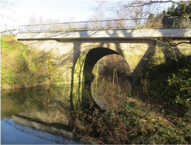
Durchlass; Ufer unterbrochen
