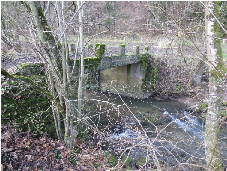
Durchlass; Ufer unterbrochen
