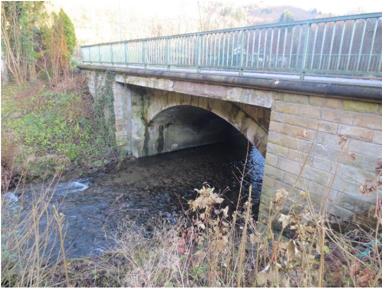
Durchlass; Ufer unterbrochen
