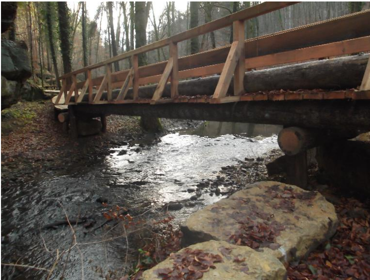
Brücke siehe Durchlass
