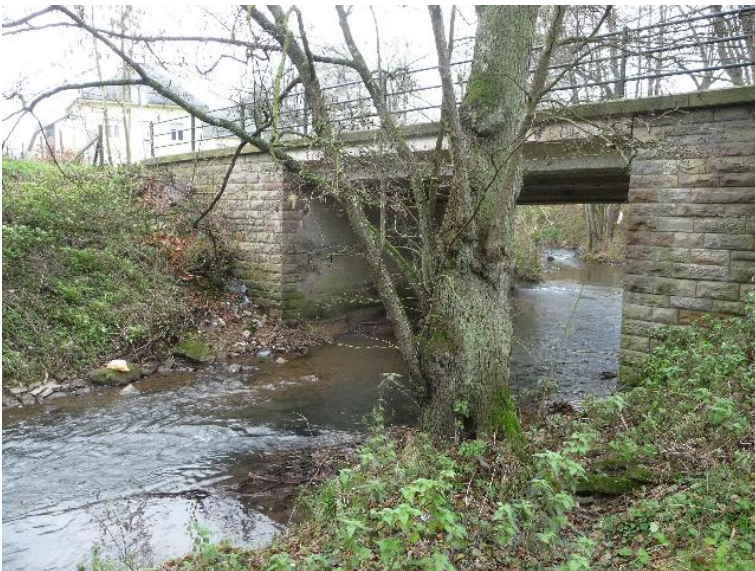
Durchlass; Ufer unterbrochen
