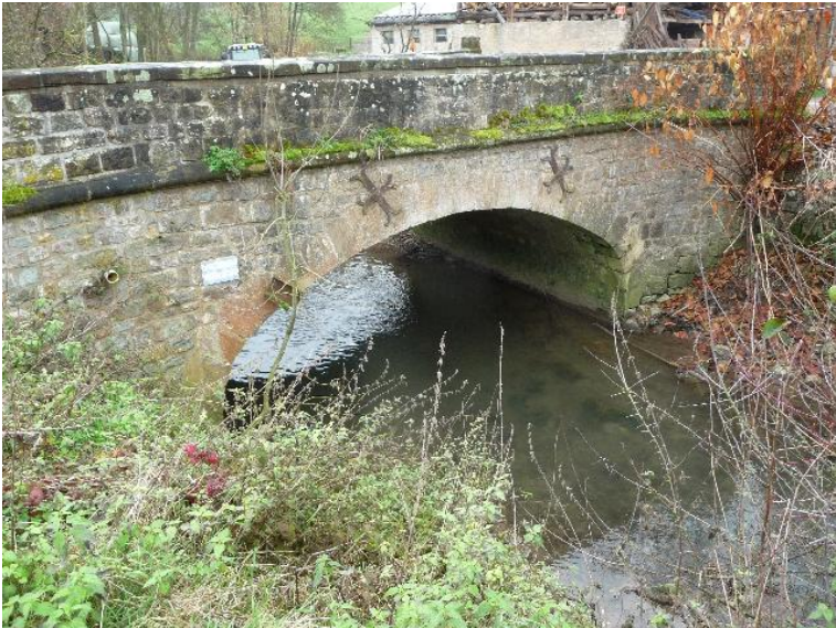
Durchlass; Ufer unterbrochen
