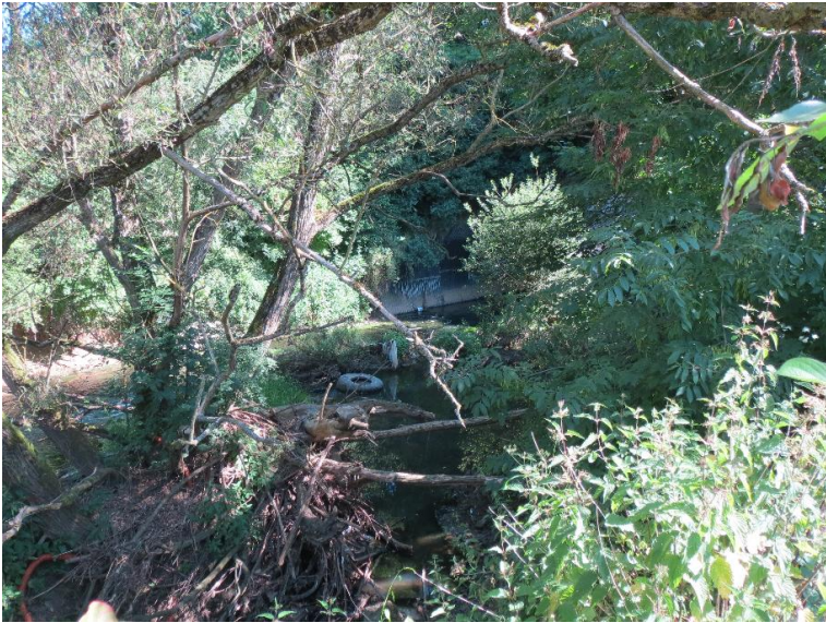
Durchlass; Ufer unterbrochen - Totholzansammlung
