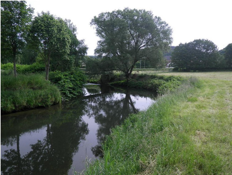
Durchlass; Ufer unterbrochen
