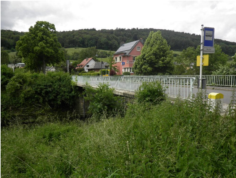
Durchlass; Ufer unterbrochen
