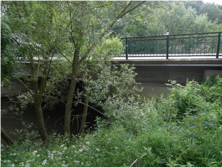
Durchlass; Ufer unterbrochen
