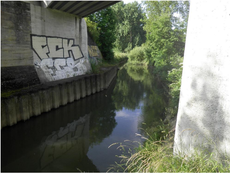
Durchlass; Ufer unterbrochen
